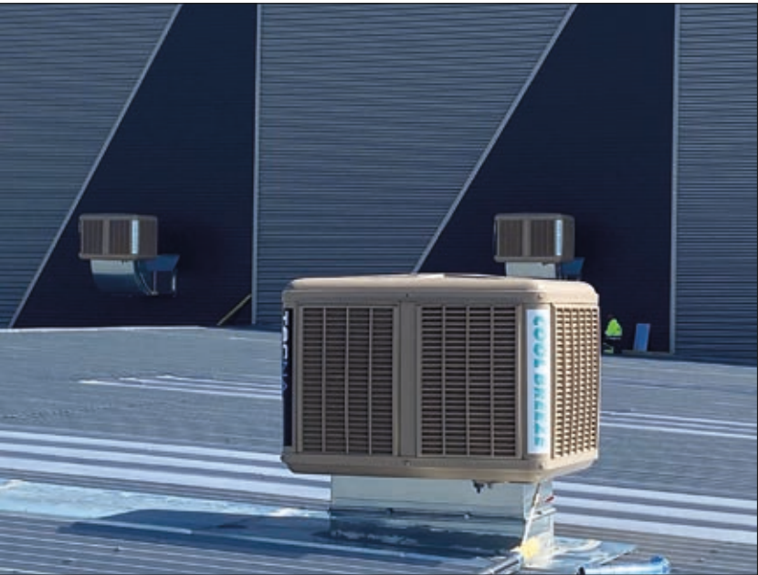
Instalación de 18 Unid. QA-500 integrados con el control domótico INTELLITOUCH en la nueva nave de NISSAN (Ávila)
